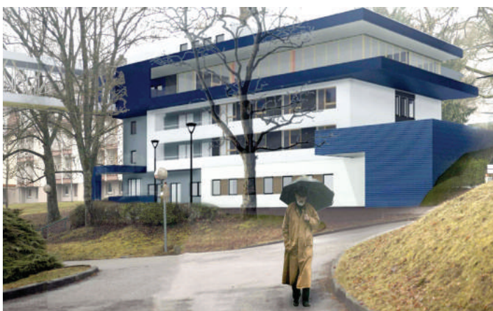
Le projet vu du côté du pavillon Emmaüs avec la passerelle qui le reliera à Siméon.
