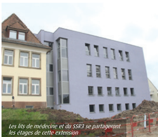
Le SSR 3 se trouve dans ce bâtiment perpendiculaire à l'ancien
