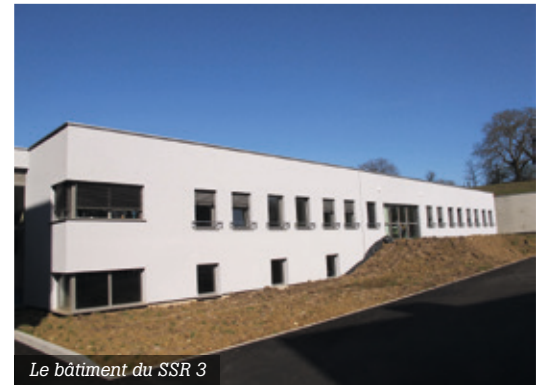
Le bâtiment du SSR 3
